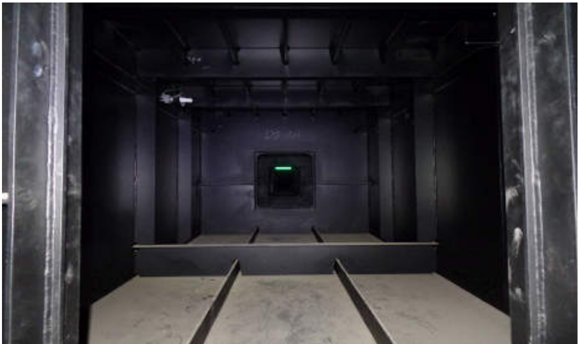
강박스 내부 전경
